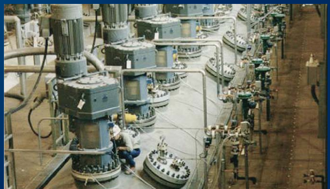
Autoklav-Behälter nach Fertigstellung
