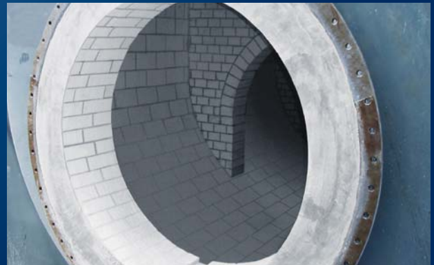
Ausmauerungen in einer Schwefelsäurerückgewinnungsanlage
