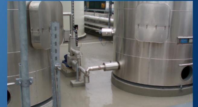
Systeme mit rissüberbrückenden, farbig pigmentierten Verlaufbeschichtungen auf Epoxidharzbasis. Die SV-AS-Ausführung hat zusätzlich eine elektrostatisch ableitende Eigenschaft.
