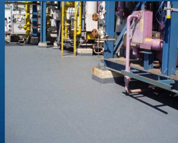
Die Stellagen ASP-Dichtschicht ist ein Beschichtungssystem auf Vinylesterharzbasis. Aufgrund der Glasfaserverstärkung ist sie schwindrissüberbrückend und wird deshalb überwiegend auf Betonflächen, insbesondere bei Auflagen aus dem Wasserhaushaltsgesetz, eingesetzt.
