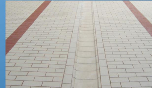
Didier SF ist ein säurefestes Steinmaterial, das zur Herstellung von verschleißfesten, chemisch und thermisch hochbelastbaren Auskleidungen und Plattierungen von Behältern, Bodenbelägen und sonstigen Bauwerksflächen eingesetzt wird.
