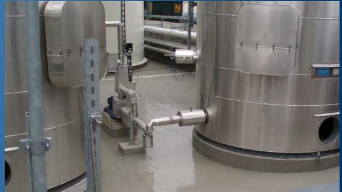
Systeme mit rissüberbrückenden, farbig pigmentierten Verlaufbeschichtungen auf Epoxidharzbasis. Die SV-AS-Ausführung hat zusätzlich eine elektrostatisch ableitende Eigenschaft.
