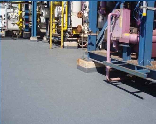
Die Stellagen ASP-Dichtschicht ist ein Beschichtungssystem auf Vinylesterharzbasis. Aufgrund der Glasfaserverstärkung ist sie schwindrissüberbrückend und wird deshalb überwiegend auf Betonflächen, insbesondere bei Auflagen aus dem Wasserhaushaltsgesetz, eingesetzt.
